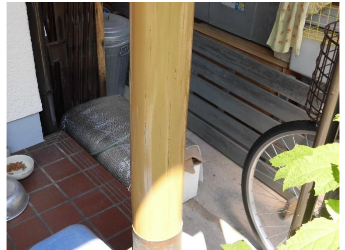
木製玄関ポーチ柱保護ペイント アフター
