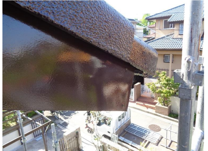
ガルバリウム板金カバー補修 アフター
