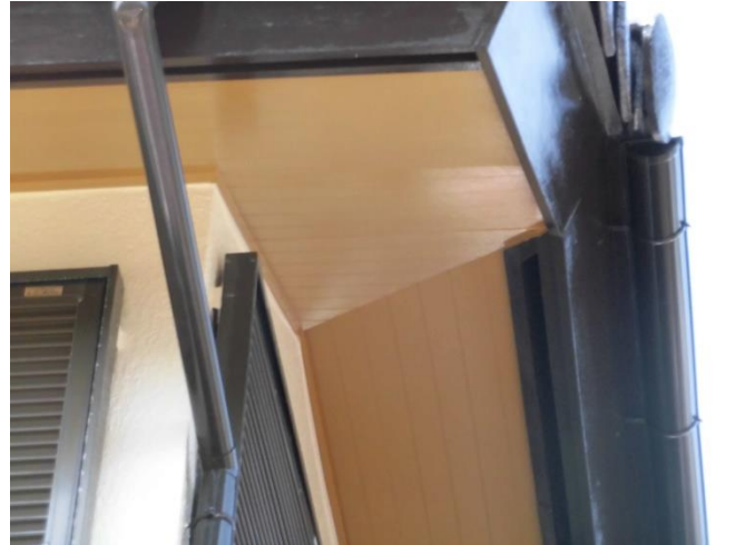
軒裏天井板部ペイント アフター
