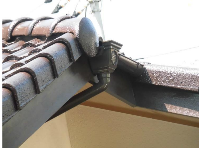
軒樋新設 アフター
