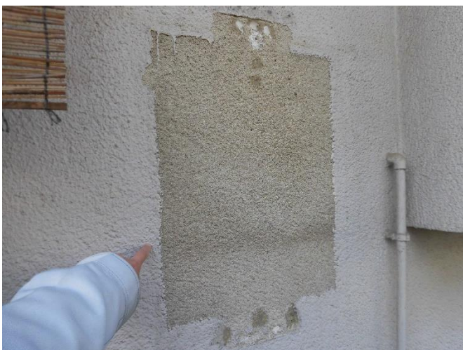
1 階外壁給湯器撤去跡 ビフォー
