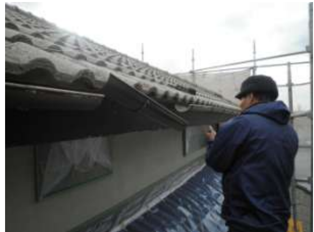
樋屋さんに修理してもらいました。
